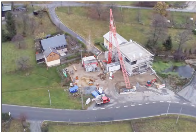
Blick von oben auf die Baumaßnahme für den neuen Anbau am Feuerwehrgerätehaus in Krumhermsdorf im November 2023, Foto: Enrico Bartsch
