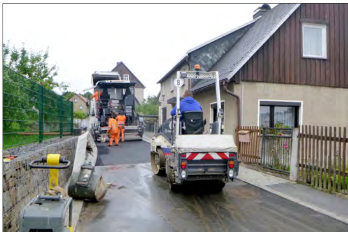
Asphalteinbau auf der Talstraße im Ortsteil Rugiswalde am 28. August 2023
